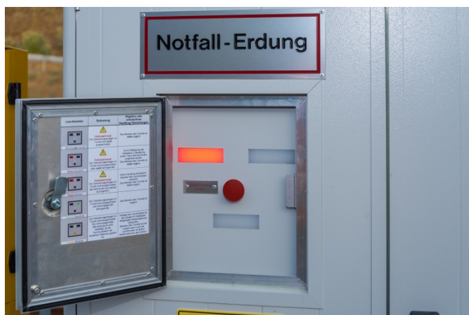
Abbildung 13: Leuchtmelder und Nottaster einer OLSP
