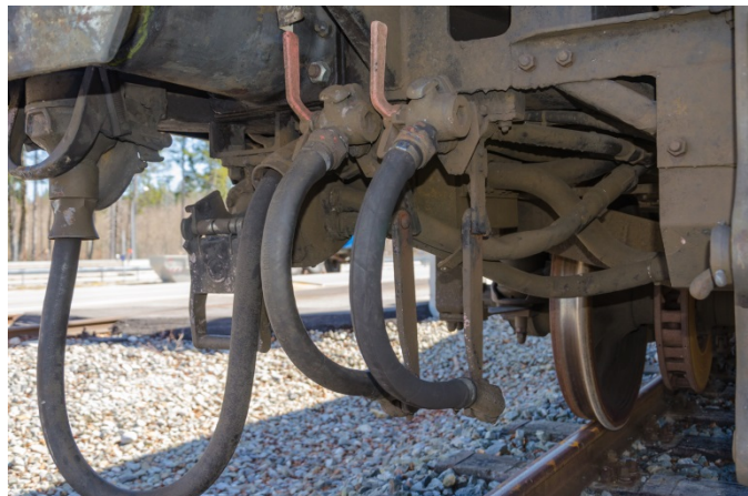
Abbildung 35: Luftleitungen mit Luftabsperrröhren
