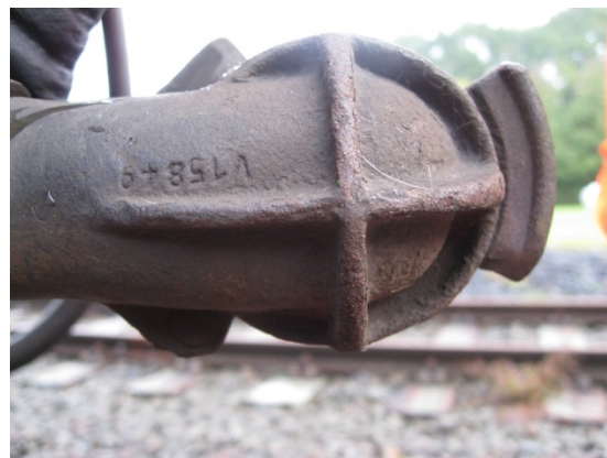
Abbildung 36: Gekennzeichneter Luftkopf einer Hauptluftbehälterleitung
