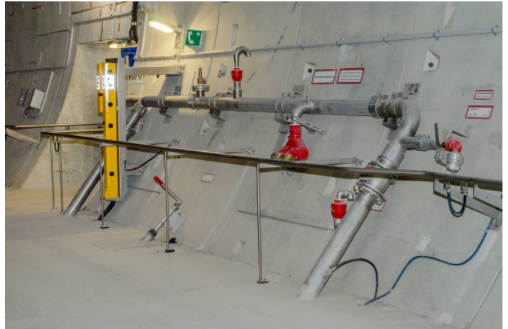
Abbildung 57: Überleiteinrichtung Löschwasserleitung (Beispiel)
